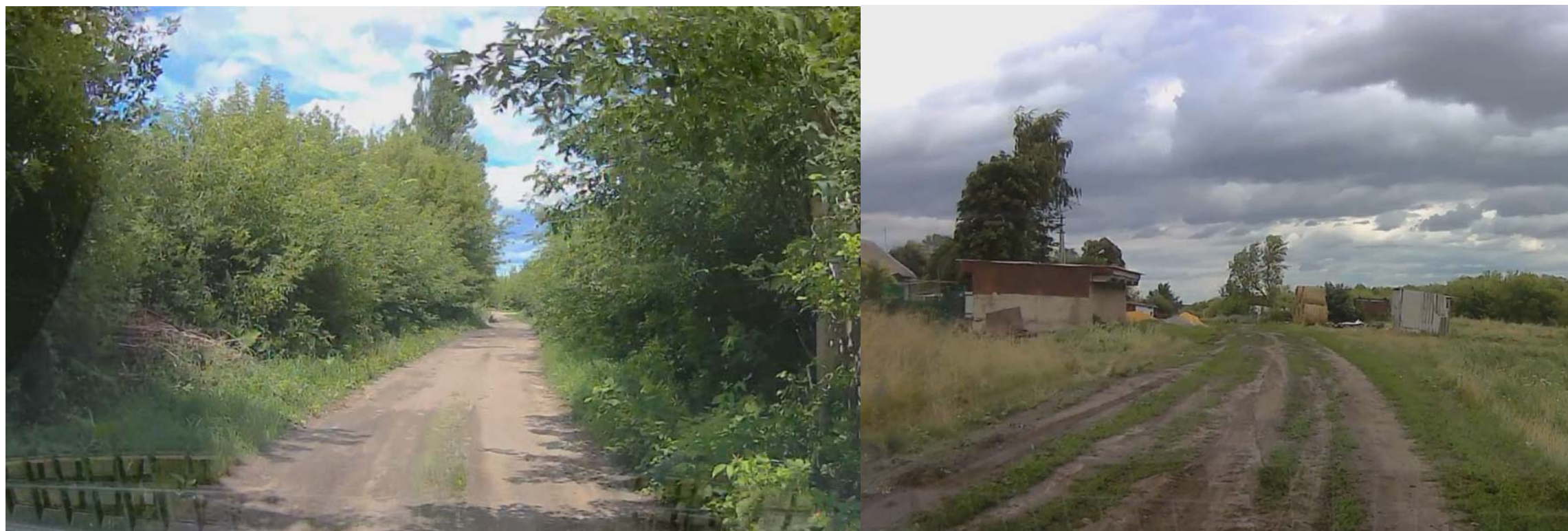
Рисунок 2 – Пример грунтового покрытия
