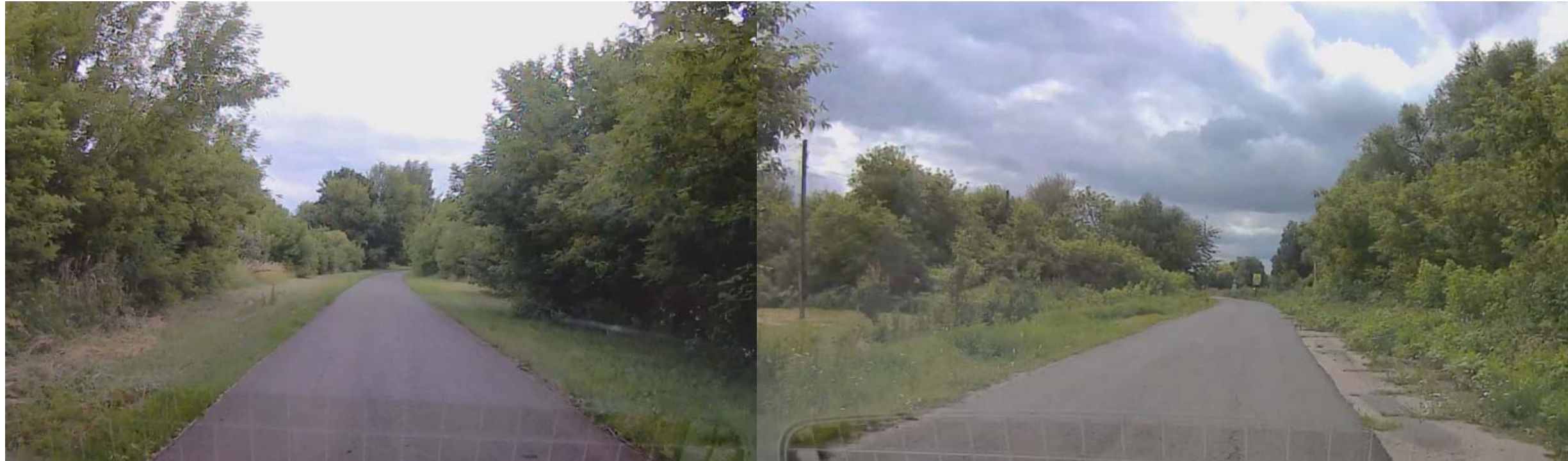
Рисунок 1 – Пример асфальтобетонного покрытия
